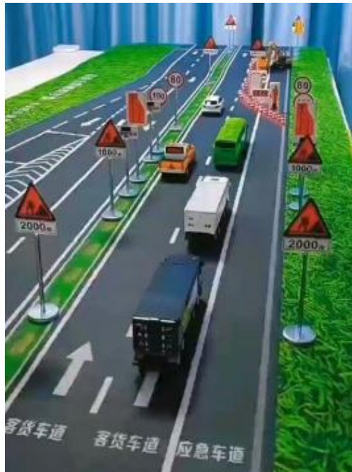
公路养护作业控制区布置图样
