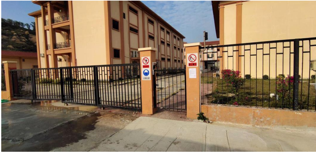
三角岛升压站
