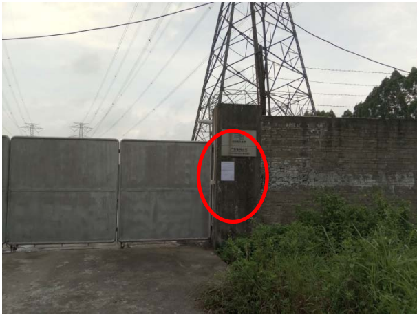
广州供电输电部石楼巡检站（远照）
