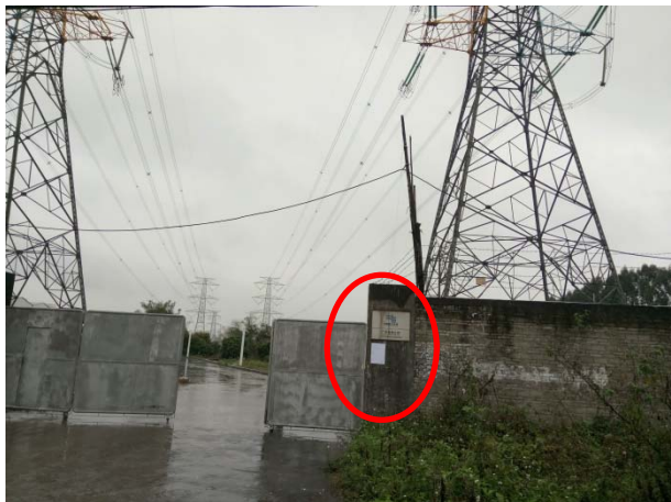
广州供电输电部石楼巡检站（远照）
