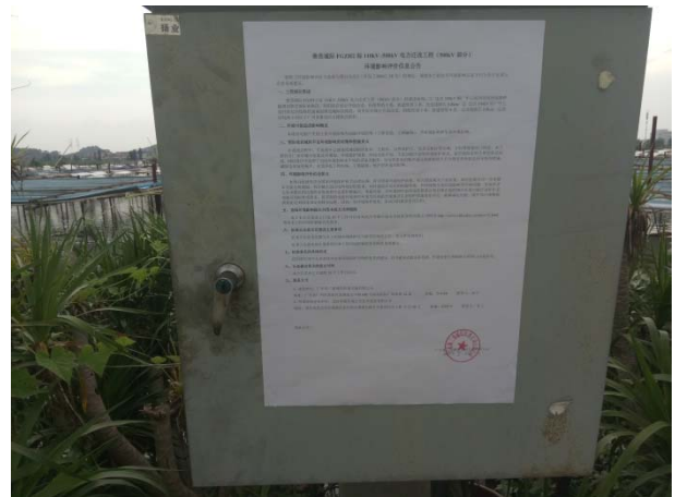
500kV 迁改段线路附近（近照）
