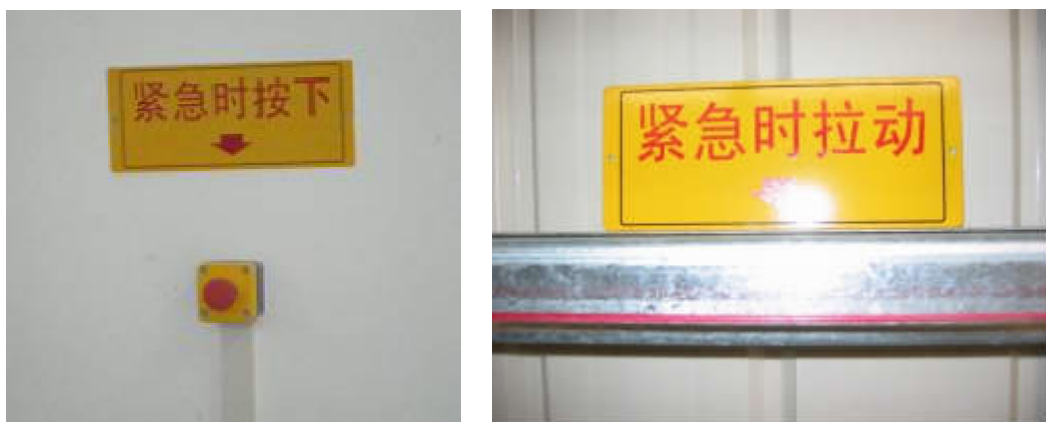
图 10-6 同型号检测系统急停按钮、急停拉线示意图
