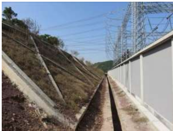
站外护坡和排水沟等水保措施
