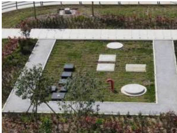
现有事故油池
